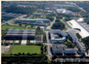
Site retenu en région francilienne pour le concours 2012 : la gare de Noisy-Champs, à Marne-la-Vallée, entre le RER A et le futur métro automatique régional Grand Paris Express.
