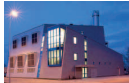
Exemple de centrale de cogénération (Green'Ovation)
