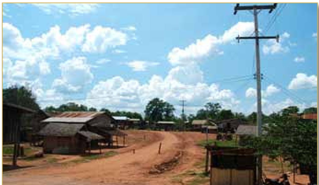
Distribution d'électricité dans les provinces rurales du Laos. © Banque mondiale/Ida
