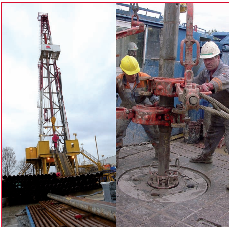
MAT DE FORAGE / SERRAGE DU TRAIN DE TIGE (Photo : ANTEA)
