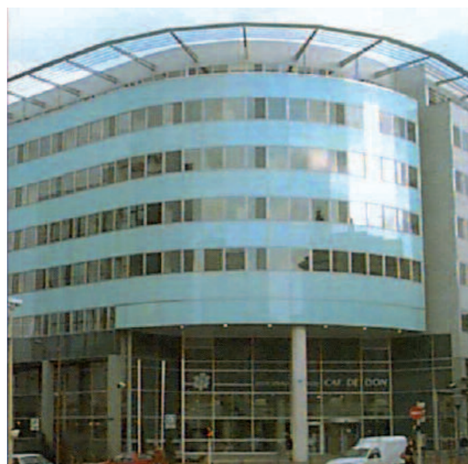
Façade du bâtiment de la CAF de Lyon
