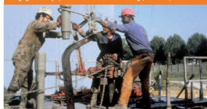
Forage géothermique, une manœuvre sur le train de tige, La Villette, Paris
