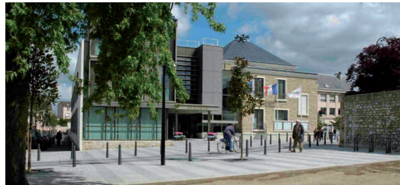
Pôle administratif des Mureaux
